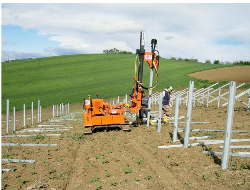
Imagem 12 - Perfuração das estacas de suporte
